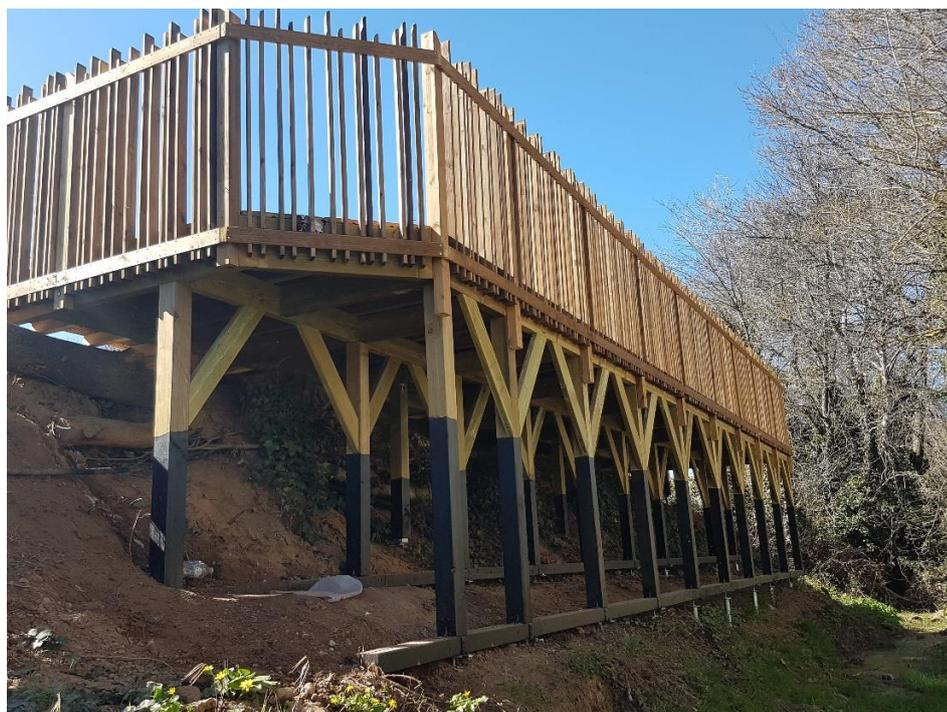
Sur un talus en sol terreux, on placera une vis enfoncée de minimum 1000 mm, mais si le talus a un angle de plus de 20°, on passera automatiquement à une vis enfoncée de minimum 1250 mm . Si la composition du sol est peu stable, on utilisera des vis plus longues jusqu'à obtenir une bonne stabilité de la vis de fondation.
