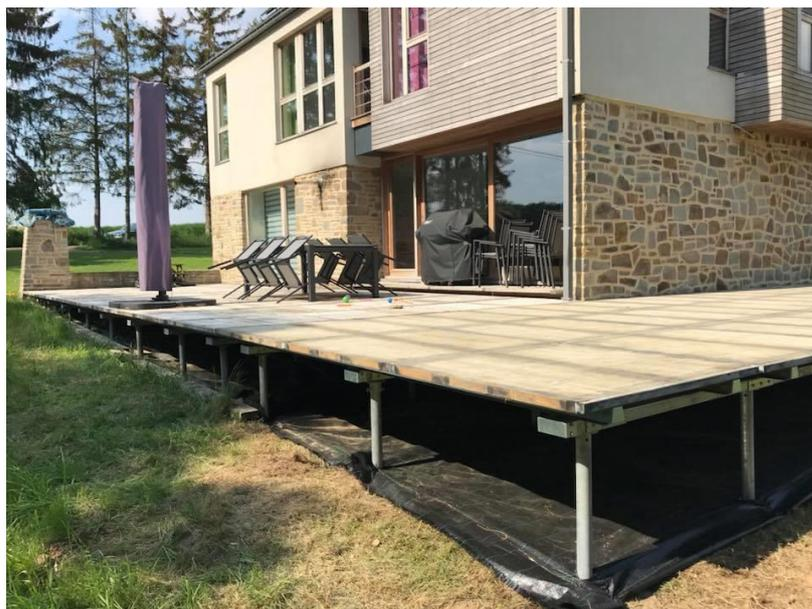
Dans le cas d'un terrain en pente, il faut distinguer, les terrains continus sans fracture et à faible pente pour lesquels on va choisir une longueur de vis en fonction du dénivelé et les talus.
