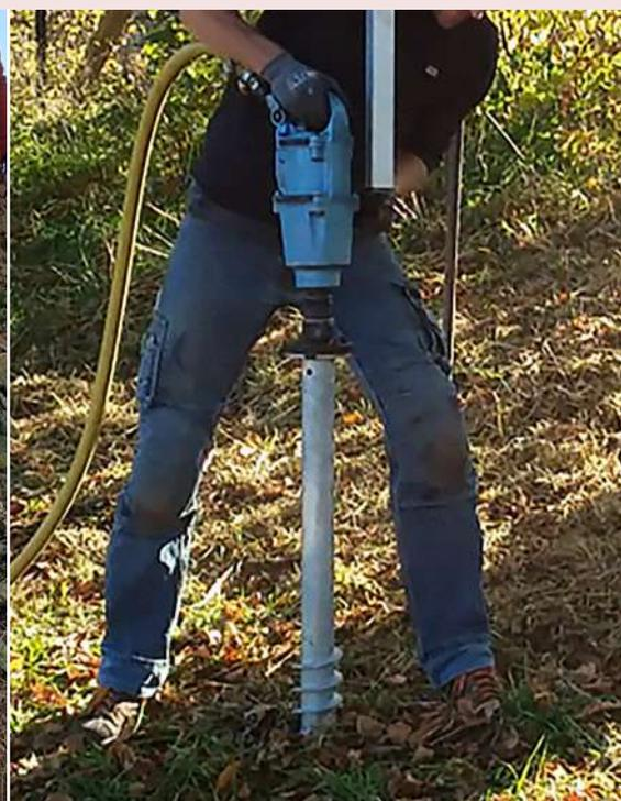
Boulonneuse à choc Makita TW 1000 pour le placement des vis de fondation. Puissance d'entraînement **1000Nm**.
